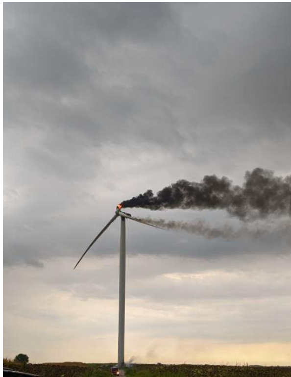
Слика 6.1: Једна од турбина ветропарка Чибук 1 потпуно уништена у пожару изазваном ударом грома у септембру 2020. године
