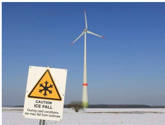
Слика 5.1: Знаци опасности у близини ветротурбина у регијама у којима се може задржавати лед на лопатицама
