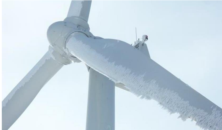
Слика 5.2: Сензори за детекцију леда држе турбину у стању мировања
