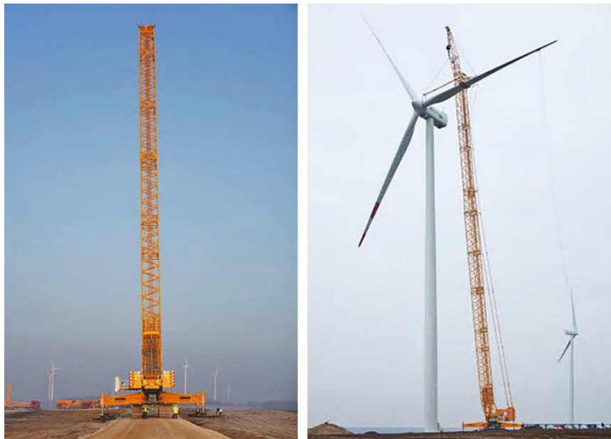
Слика 3.1: Кран, тешка механизација присутна у фази изградње ветропарка
